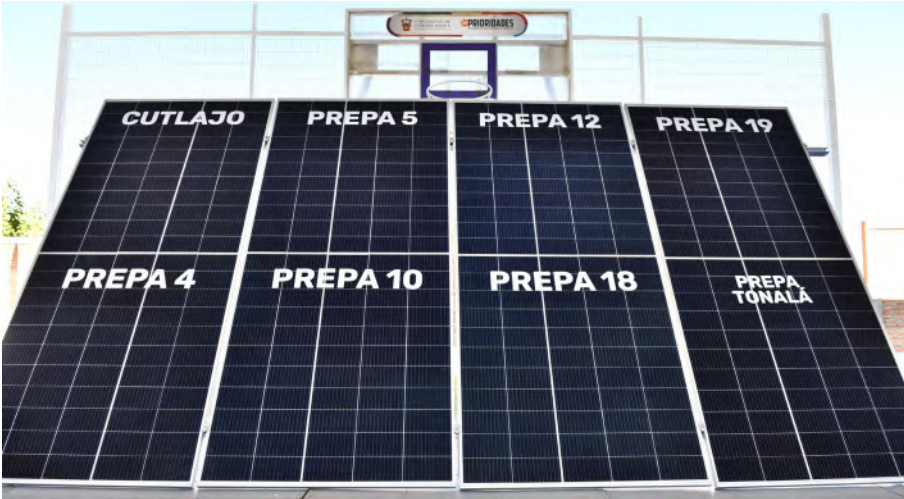
Panteles universitarios con instalación de paneles solares
